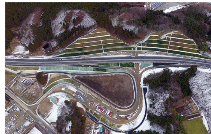
高速道路スマートインターチェンジの工事 (山和建設施工)
