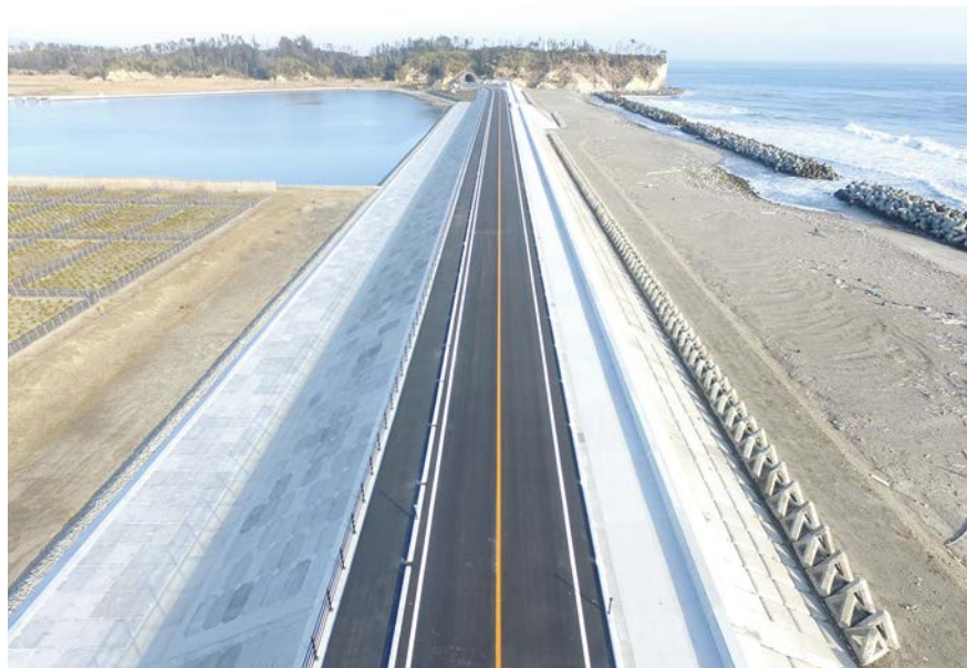
津波被災を受け寸断されていた大洲海岸の復旧工事 (小野中村施工)
