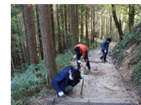
ルート補修作業の様子
