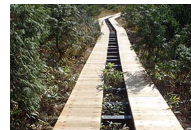
尾瀬木道整備工事 (希少動植物の生態系保護に配慮)
